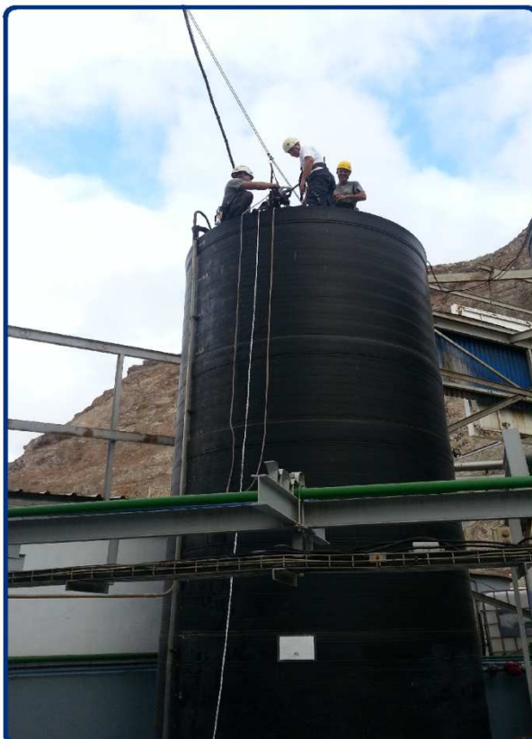
Operación de Ascenso-Descenso para el acceso al interior de un tanque
