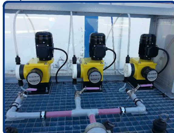
Detalle de Estructura Anti-salpicaduras para la Conexión de Suministro de tres bombas dosificadoras en PVC tratado con fibra de vidrio y esmalte
