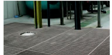
> **Cuadrada 30x30:** espesores de 25,30 y 38 mm para circulación de peatones y cargas pesadas.
