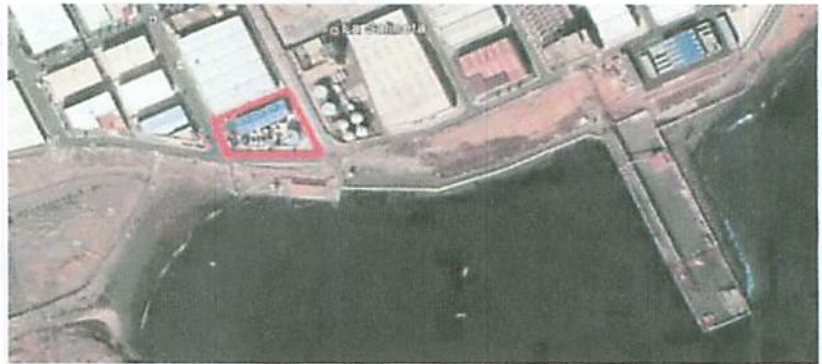
Foto 6. Imagen de Situación de la Instalación
