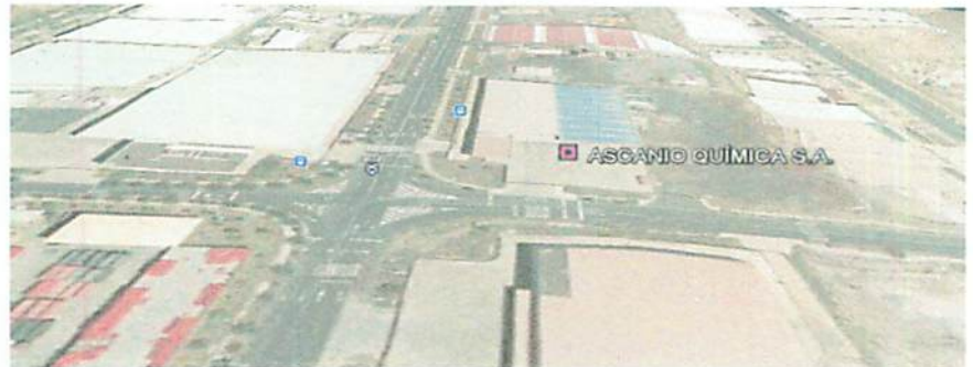
Foto 3. Imagen de situación en el polígono del Almacén General de Güímar
